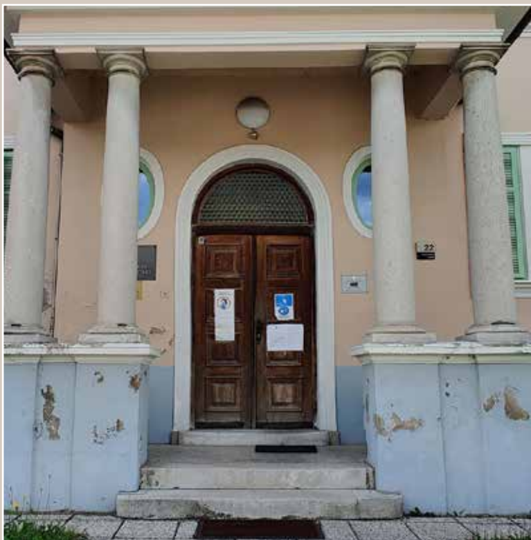
Okrajno sodišče v Ilirski Bistrici (Bazoviška cesta, 22)
