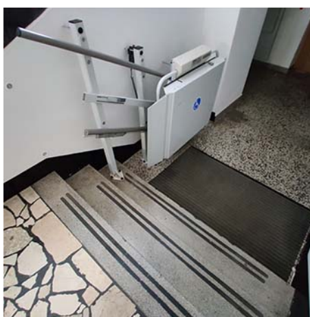
Slika 53:Primeri dobre prakse vertikalnih komunikacij – kontrastno označeno stopnišče z čeli in brez previsov, ter v kombinaciji s posluževanjem dvigal in dvižnih ploščadi.
