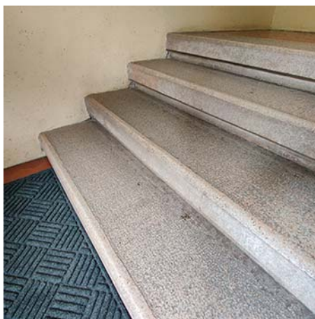
Slika 52:Primeri slabe prakse vertikalnih komunikacij – stopnišča brez čel, s previsi, pomanjkanjem kontrastnih oznak in ustreznih oprijemal.
