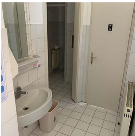
Slika 57:Primeri slabe prakse ureditve sanitarij – številni predprostori in ožine, ni zadostnega manevrskega prostora in drugih prilagoditev opreme.
