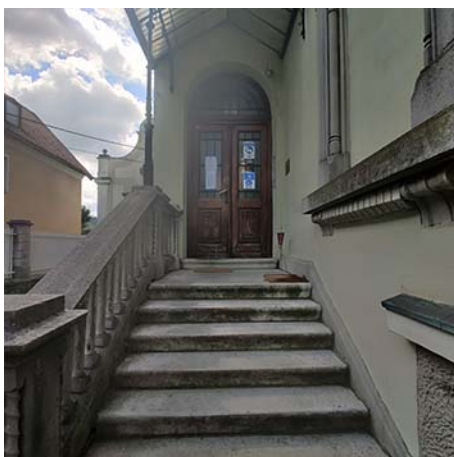
Slika 47:Primeri slabe prakse vhoda - Neurejena stopnišča in težka stara vrata, ki ne omogočajo samostojne uporabe.
