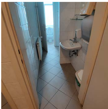
Slika 57:Primeri slabe prakse ureditve sanitarij – številni predprostori in ožine, ni zadostnega manevrskega prostora in drugih prilagoditev opreme.
