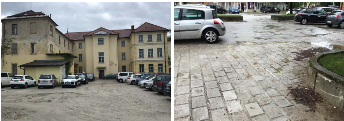
Slika 41: Primer lastniškega parkirišča sodišča v Radovljici z neurejenim parkiriščem.
