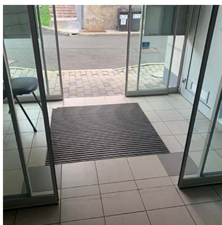
Slika 48:Primeri dobre prakse vhoda - klančine in izravnani prag avtomatičnih vrat.
