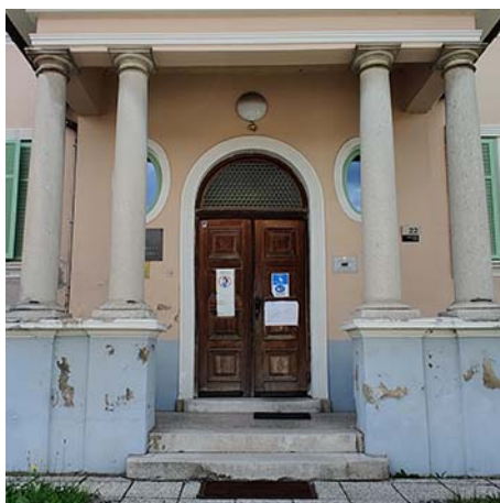
Slika 47:Primeri slabe prakse vhoda - Neurejena stopnišča in težka stara vrata, ki ne omogočajo samostojne uporabe.
