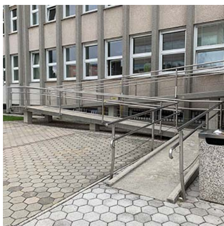
Slika 48:Primeri dobre prakse vhoda - klančine in izravnani prag avtomatičnih vrat.
